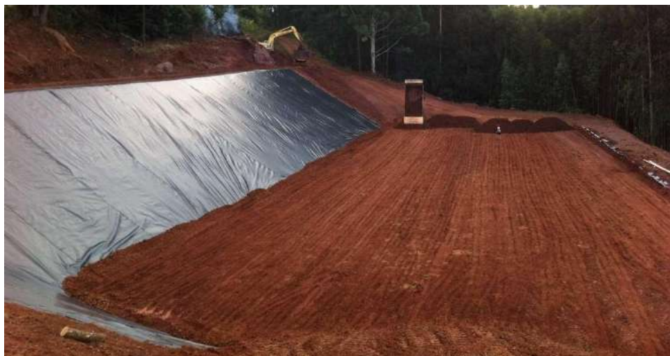
Figura 29: Base da célula devidamente impermeabilizada. Fonte: Aterro Sanitário CRI Ltda em Ipumirim SC.
