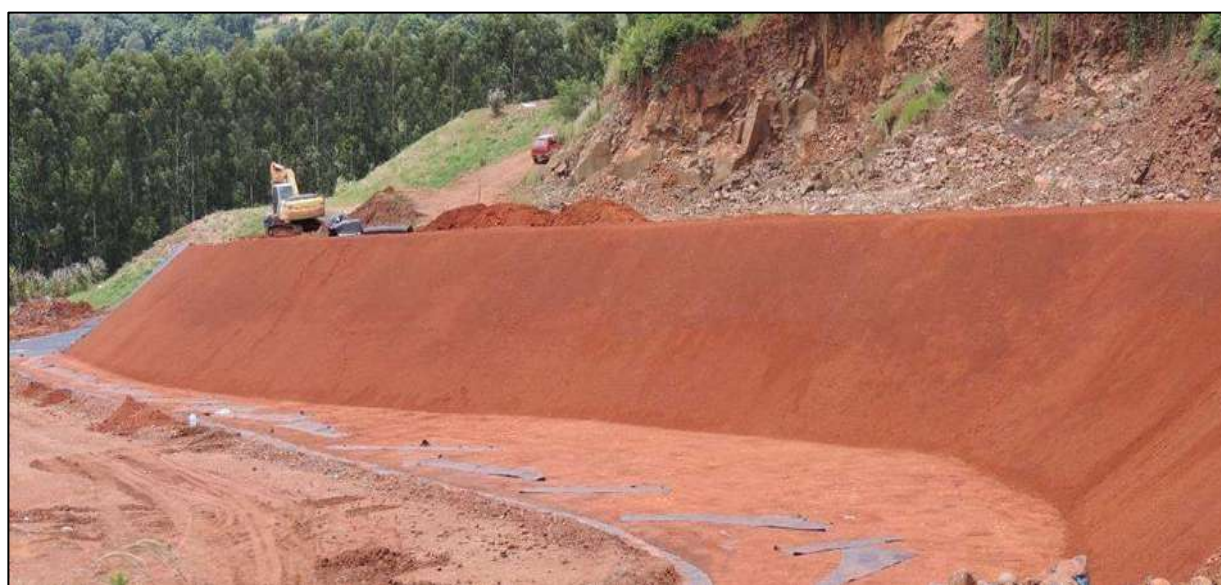
Figura 18: Terraplenagem em aterro sanitário. Fonte: Aterro Sanitário CRI Ltda.
