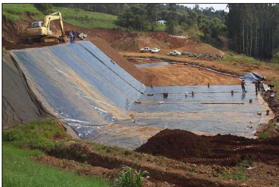
Figura 19: Impermeabilização da área de depósito. Fonte: Aterro Sanitário CRI Ltda em Ipumirim/SC
