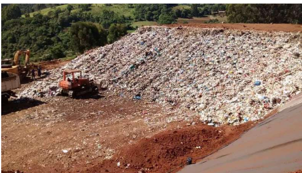
Figura 31: Espalhamento e compactação dos resíduos. Fonte: Aterro Sanitário CRI Ltda em Ipumirim SC
