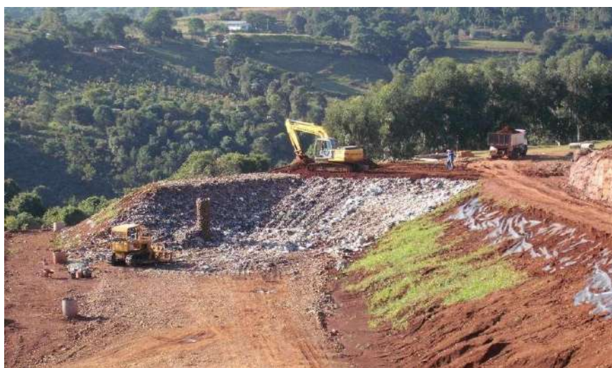
Figura 30: Frente de serviço. Fonte: Aterro Sanitário CRI Ltda em Ipumirim SC
