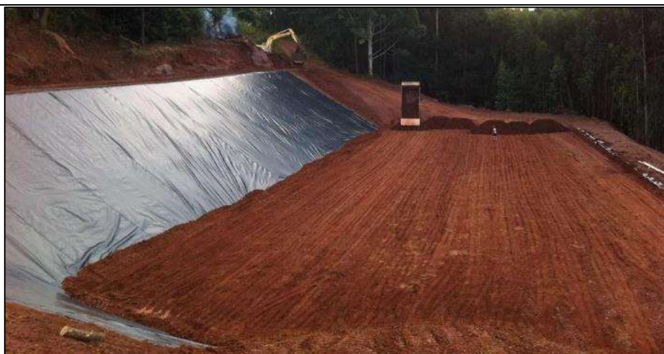
Figura 20: Proteção da geomembrana. Fonte: Aterro Sanitário CRI Ltda em Ipumirim/SC
