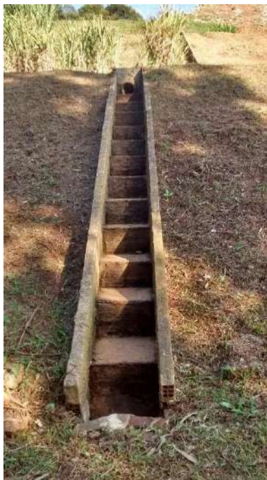
Figura 34: Descida de água.
